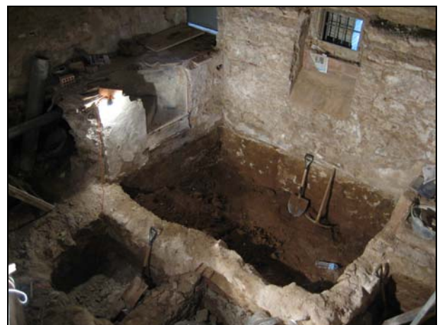
FOTO 8. Vista general un cop finalitzats els treballs de remoció de terres
