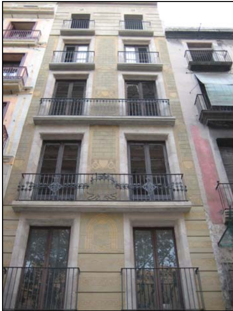
FOTO 1. Façana de la Rambla de l'edifici on s'ha dut a terme la intervenció
